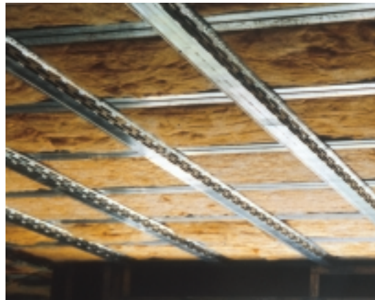
Abb. 56 (oben): Resilient Channels zur schalltechnisch entkoppelten Befestigung der Unterdecke an den Tragprofilen (Profilhaus, Ettlingen)
