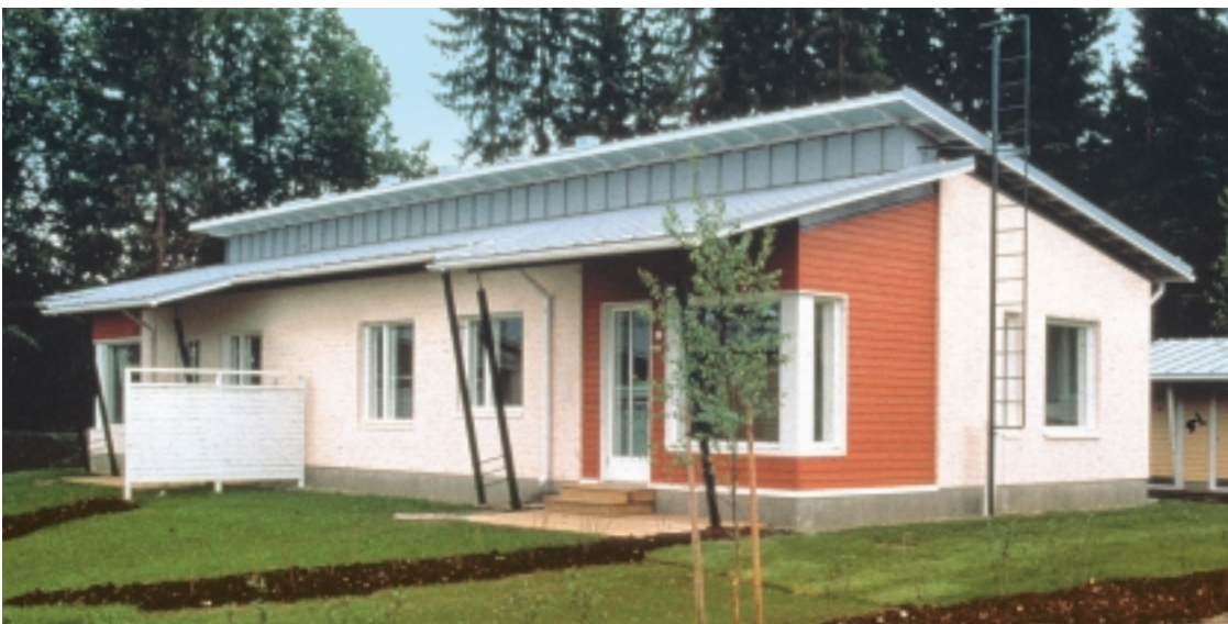
Abb. 2, 3, 4: Gebäude in Stahl-Leichtbau- weise im Rohbau und nach der Fertigstellung (Rautaruukki Oyj, Finnland)
