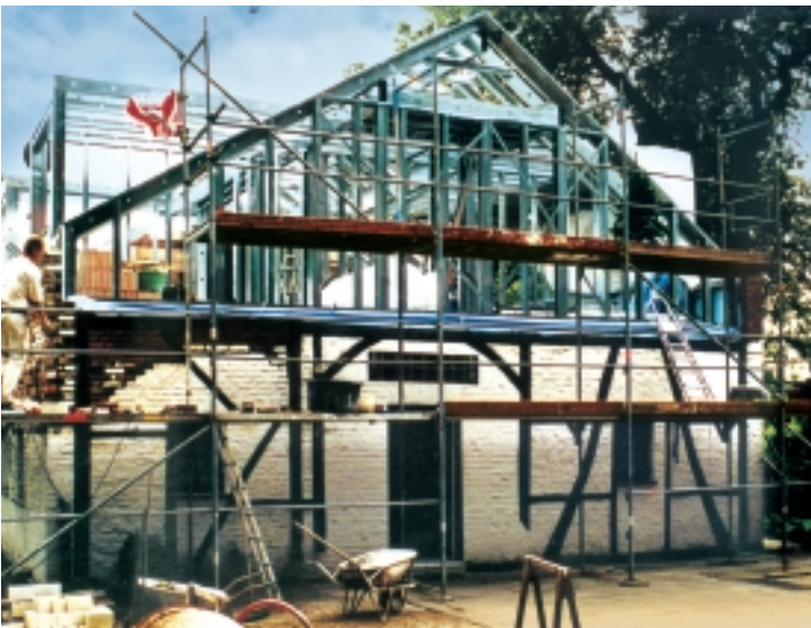
Abb. 8: Aufstockung eines Fachwerkhauses aus dem 17. Jh. (Rasta-Haus GmbH, Wesel). Aufgrund der Gewichts- beschränkung des Aufbaus war die Konstruktion allein in Stahl-Leichtbauweise möglich.
