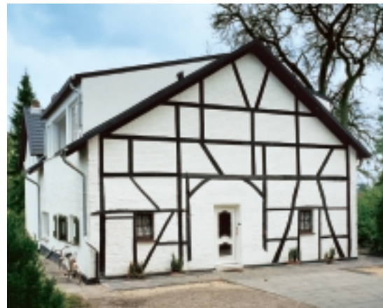
Aufstockung eines historischen Fachwerkhouses in Dinslaken (Rasta-Haus, Wesel)
