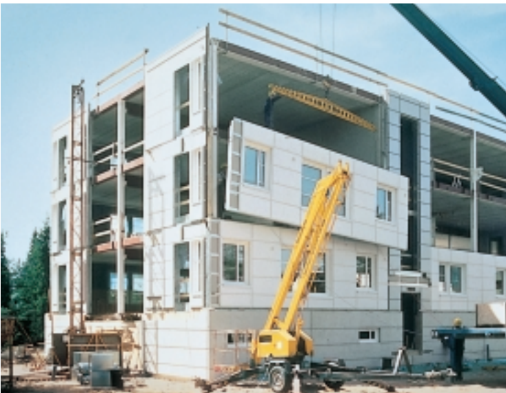
Abb. 47: Baustellen- montage von Fertigteilen (Rautaruukki Oyj, Finnland)
