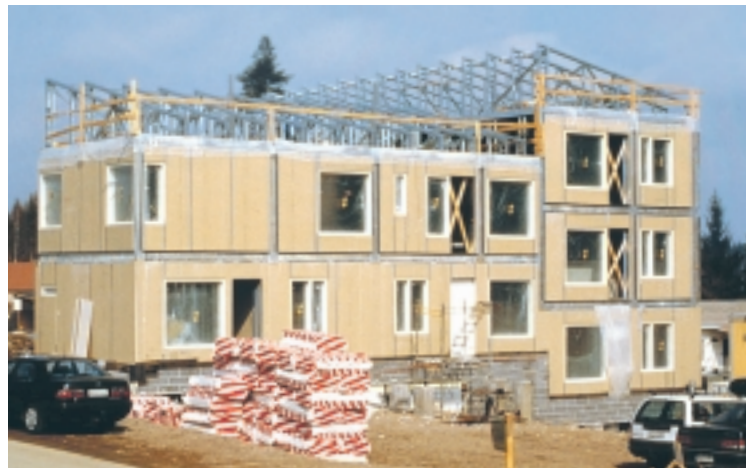
Abb. 30, 31 (unten): Aus vorgefertigten Tafeln errichtetes Gebäude in Stahl-Leichtbauweise (Rautaruukki Oyj, Finnland)
